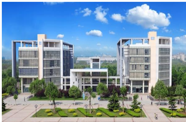
本科生实验楼
