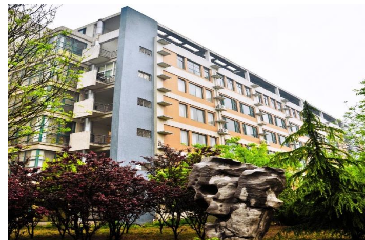
生物工程学院教学实验楼
